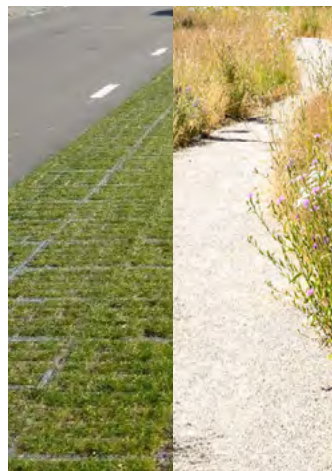
Projektuojamos vandeniui pralaidžios dangos: keliukai ir parkavimas - žolės korio dangą, takai - skaldelė.
