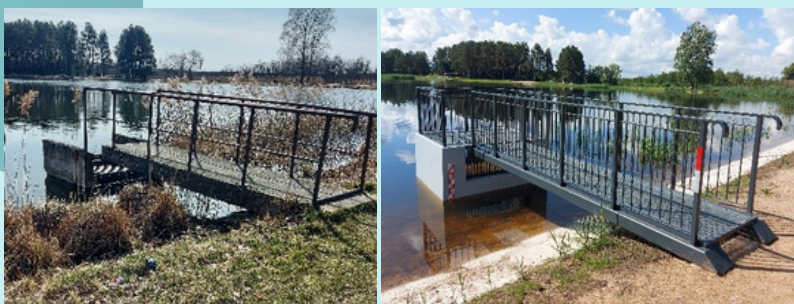
Gudienos I tvenkinio hidrotechninio statinio įtekėjimo dalies vaizdas prieš ir po remonto
