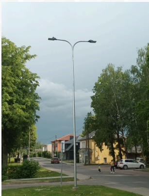
Gatvių apšvietimo modernizavimas
