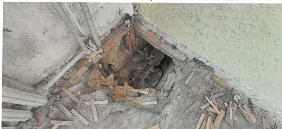
2 pav. Defektų fotofiksacinė medžiaga: 1) nusėdę grindys (4-5 cm), 2-3) trūkimai pertvarinėse sienose, 4) esami šildymo sistemos vamzdžiai
