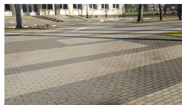
ŠVIESIOS IR TAMSIOS SPALVOS BETONINIŲ TRINKELIŲ DANGA
