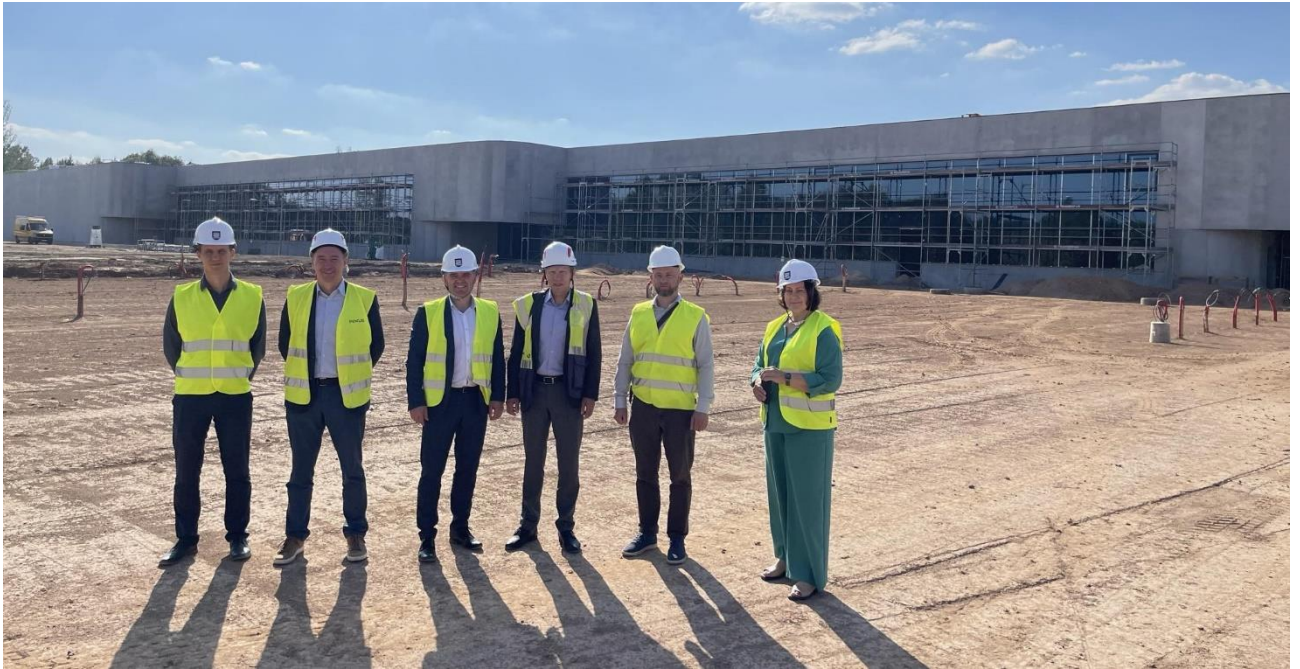
UAB „Komfovent“ gamyklos statybų aikštelėje
